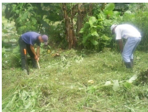
Foto 4.6: Marcación con estacas
